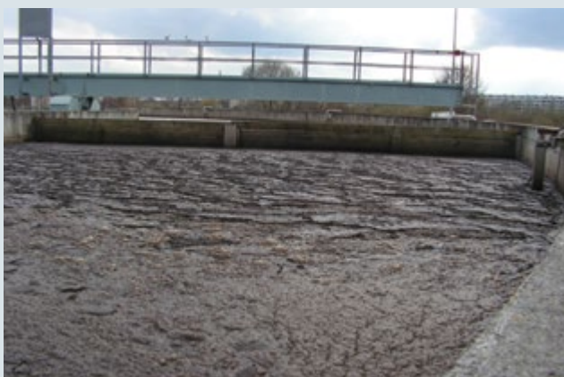
Zdjęcie nr 3. Komora osadnika wtórnego przed i podczas stosowania wkładów GREASOLUX
